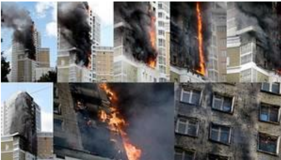
Brennende gedämmte Fassaden. Bild Konrad Fischer
