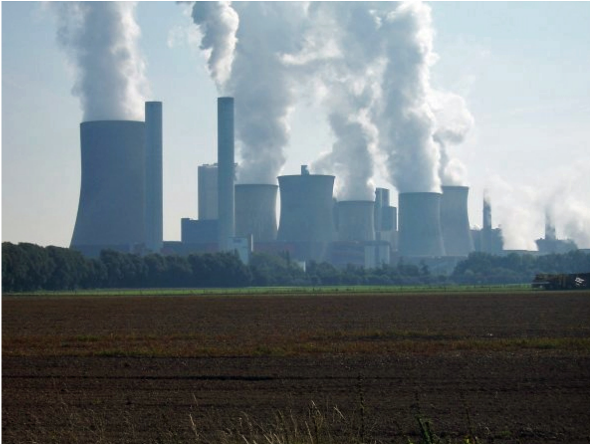
Hightech-Auspuffanlage eines deutschen Stromers Niederaußem (Foto: Kohlekraftwerke.de)
