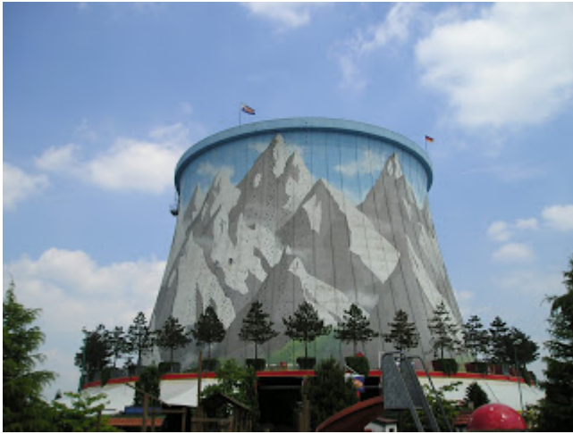
Der bemalte Kühlturm des SNR 300 in Kalkar als Klettergerüst Übernommen vom Rentnerblog hier
